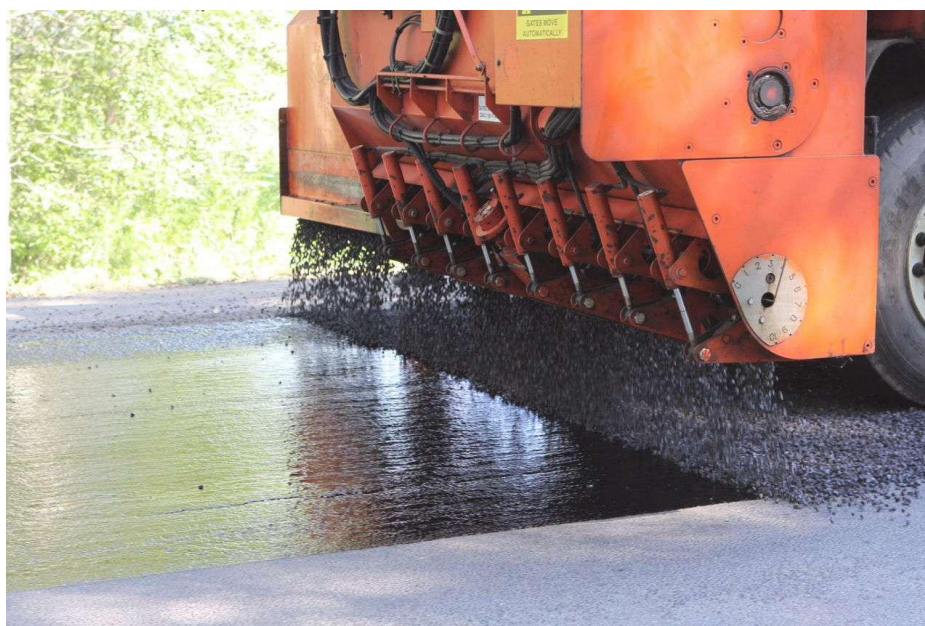
Процесс устройства слоя износа по технологии «Чип Сил»
