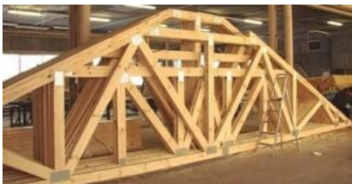
Рис. 1. Применение зубчатых металлических пластин в деревянных конструкциях
