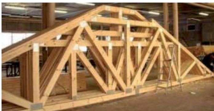
*Рис. 1.* Применение зубчатых металлических пластин в деревянных конструкциях
