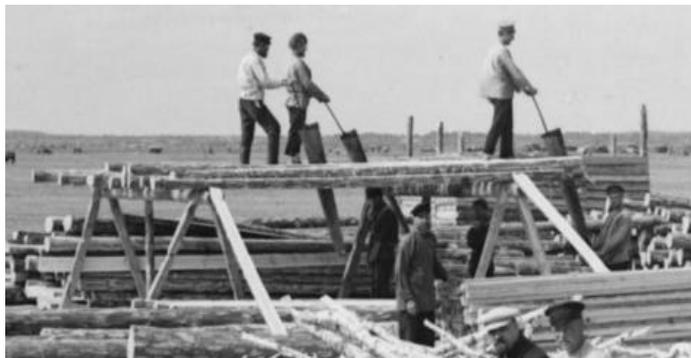
*Рис. 1.* Распиловка бревен на доски вручную
