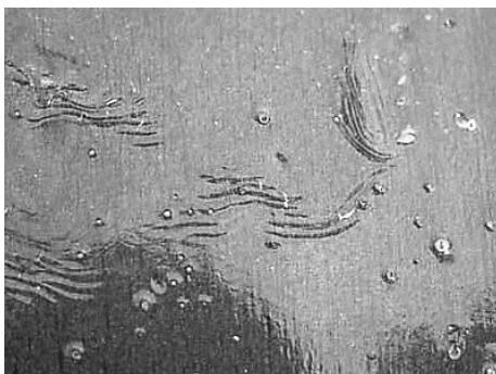
Рис. 1. Пузыри на лакокрасочном покрытии
